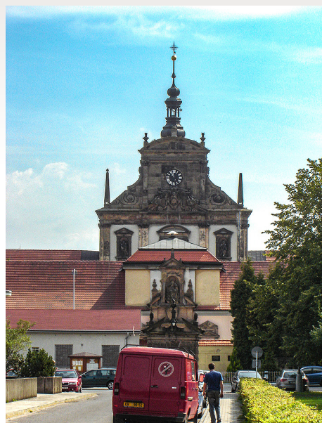
Klášterní kostel ve Valdicích
